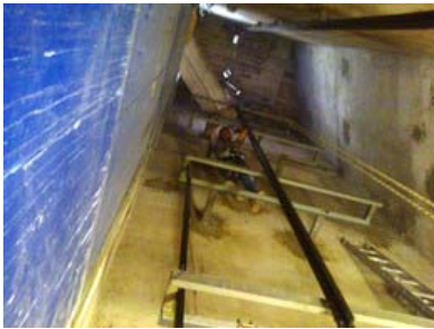
Kletterschacht vor dem Ausbau
